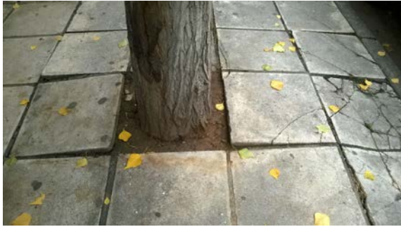
Σχήμα 6.23 Παράδειγμα δαπέδου πεζοδρομίου σε κακή κατάσταση
