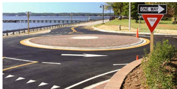
Σχήμα 6.2 Mini roundabout με προστατέσιμη κεντρική νησίδα για τα βαρέα οχήματα
