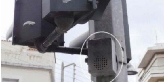
Σχήμα 6.16 Τυπική ηχητική διάταξη σε σηματοδότη για την εξυπηρέτηση των απόμων με προβλήματα όρασης
