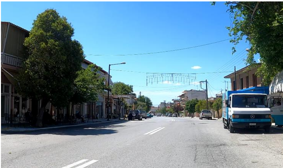
Εικόνα 1-16: Εμπόδια στο πεζοδρόμιο μειώνουν αισθητά το ελεύθερο λειτουργικό πλάτος για την ασφαλή κίνηση των πεζών στην οδό Μ.Αλεξάνδρου
