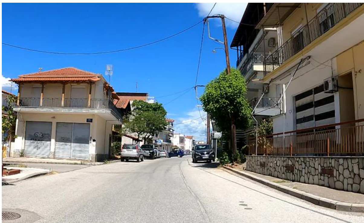
Εικόνα 1-19: Ανυπαρξία ή μειωμένο πλάτος πεζοδρομίων σε διάφορες οδούς της πόλης
