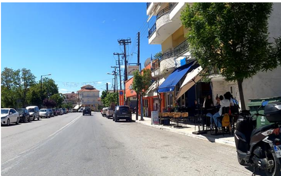
Εικόνα 1-17: Εμπόδια στο πεζοδρόμιο μειώνουν αισθητά το ελεύθερο λειτουργικό πλάτος για την ασφαλή κίνηση των πεζών στην οδό Μ.Αλεξάνδρου
