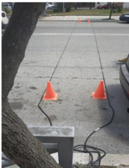
Εικόνα 1-9: Θέση μέτρησης στην οδό Μ.Αλεξάνδρου
