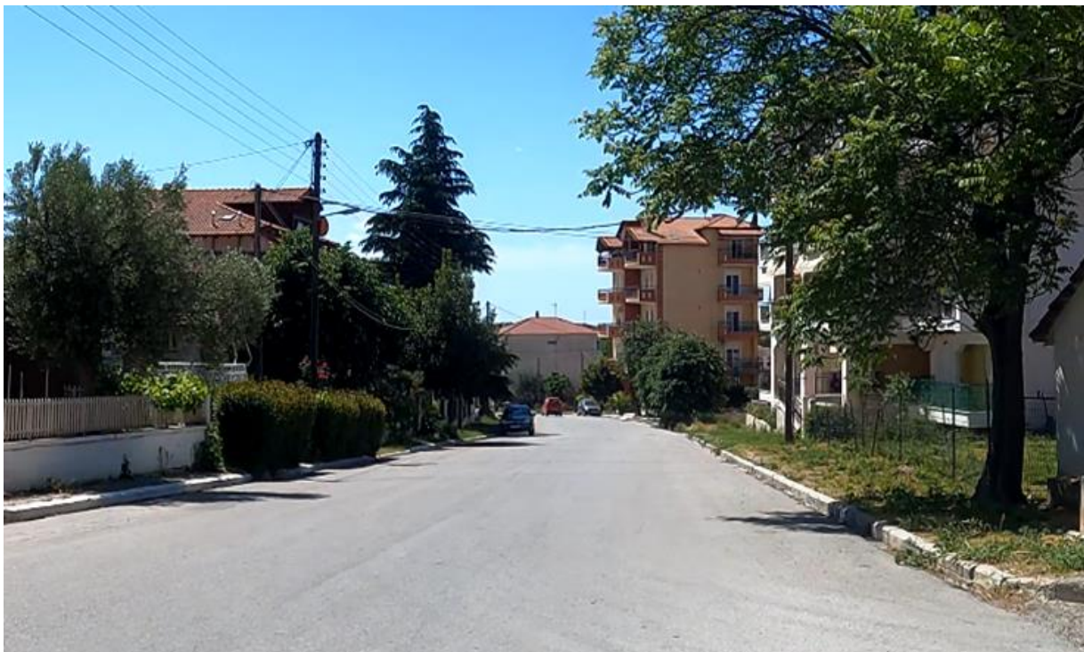
Εικόνα 1-18: Ανυπαρξία ή μειωμένο πλάτος πεζοδρομίων σε διάφορες οδούς της πόλης
