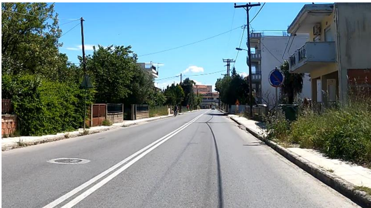
Εικόνα 1-20: Ανυπαρξία ή μειωμένο πλάτος πεζοδρομίων σε διάφορες οδούς της πόλης
