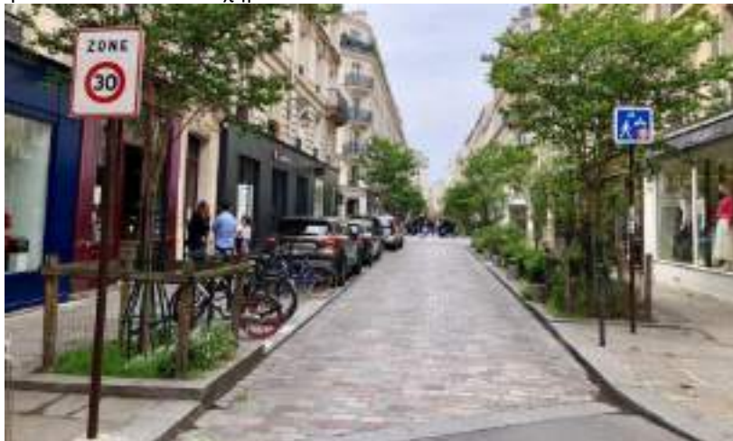
Αλλαγή υφής στο σύνολο του οδοστρώματος
