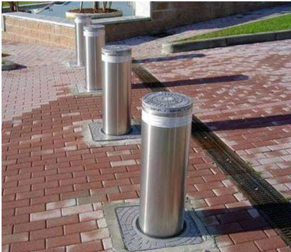
Εικόνα 4-48: Παράδειγμα ανακλινόμενων εμποδίων και αυτοματοποιημένες διατάξεις περιορισμού πρόσβασης
